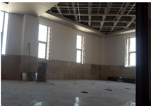
نصب درب و پنجره های دوجداره در راستای جلوگیری از هدررفت انرژی
